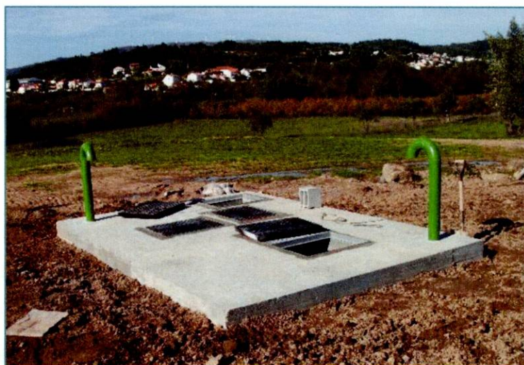
Figura 5 – Aspeto exterior da câmara de válvulas (Nó 1.21)
