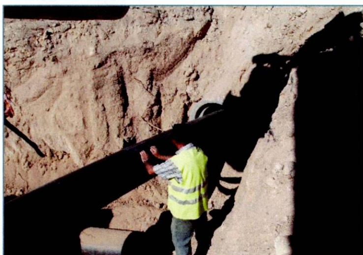
Figura 1 – Tubagem PEAD DN 400 a ser colocada no negativo de uma travessia de estrada
