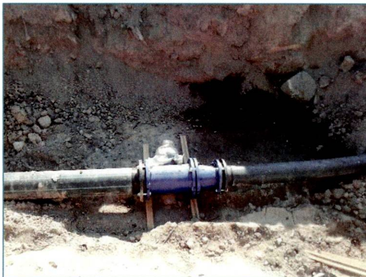
Figura 2 – Aspeto da tubagem instalada com acessórios em FFD acoplados
